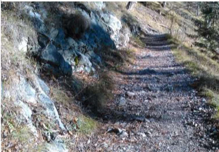
Ansicht 1 Weg durch Bagger hergestellt
