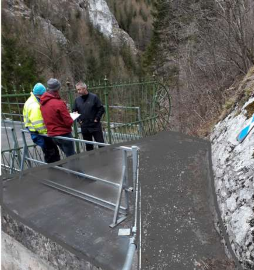
Ansicht 3 Aquädukt Betonplatte
